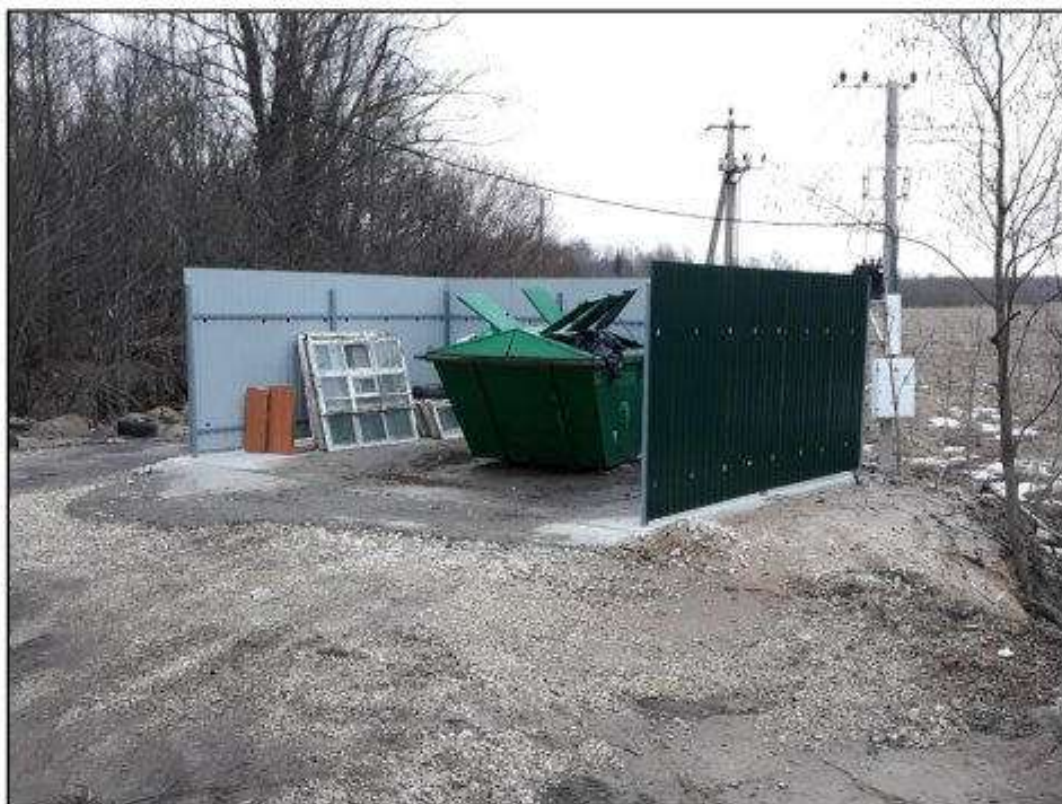
Фото 2 – перед д. 2, Контейнеры ТКО
